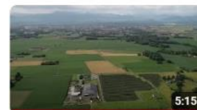
Parc Solaire d'Oursbelille, développé par le SMAEP-T...
