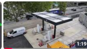
Chantier station hydrogène H2 Créteil
