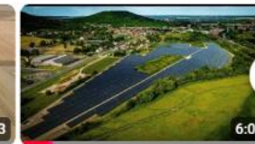
Parc Solaire de l'Espace du Génie à Ecrouves (54)
