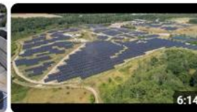
Parc Solaire de l'Ecoparc de Mercey (27)
