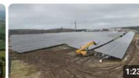
Timelapse du chantier de la centrale solaire entre Juine ...
